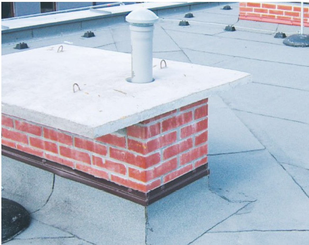
Rysunek nr 5. Wykończenie obróbki papowej komina
